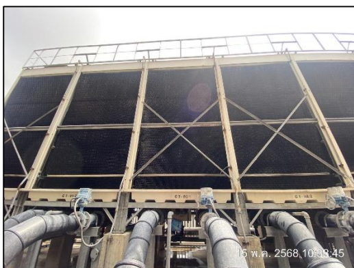
ภาพที่ 48 หอผึ่งเย็น (Cooling Tower)
